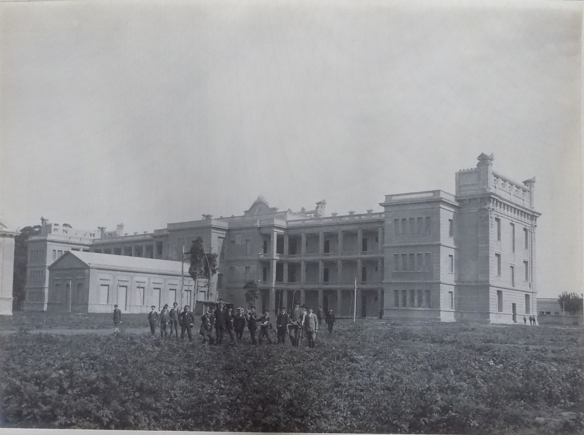
Edificio principal, vista posterior
