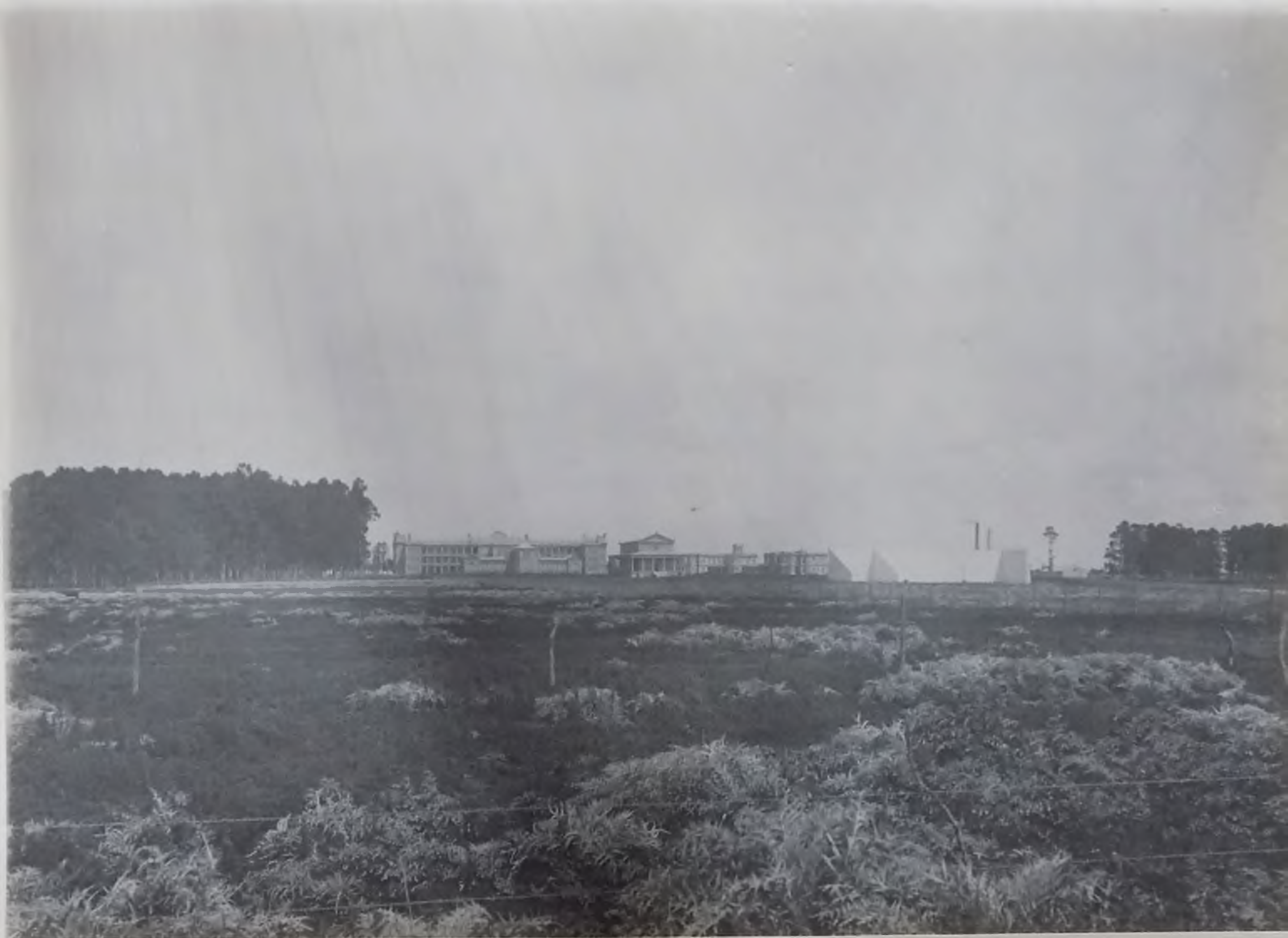
Vista general de todos los Edificios
