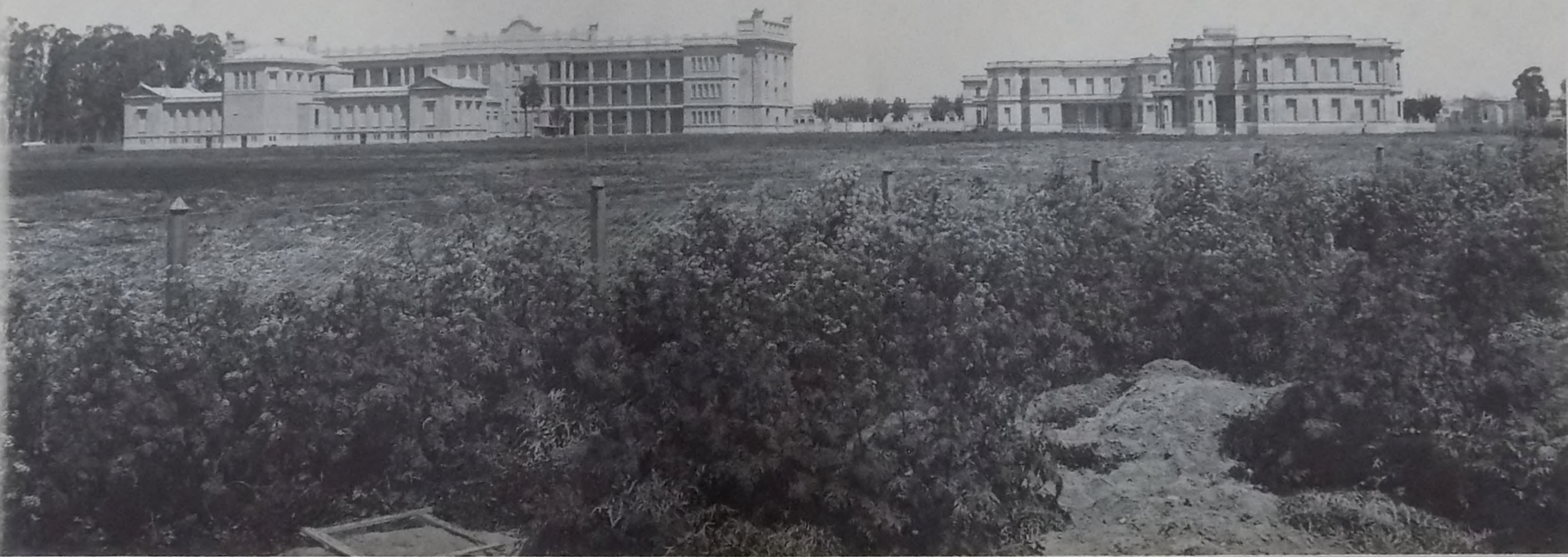
Edifícios. Física, Química, principal e internados (vista posterior)
