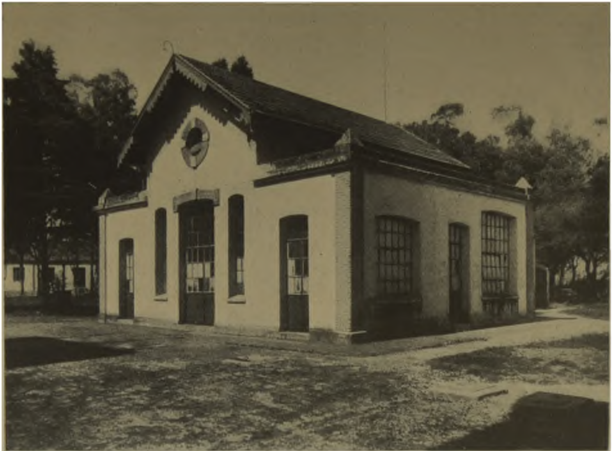
ESCUELA PRÁCTICA DE AGRICULTURA Y GANADERÍA DE SANTA-CATALINA. Usina eléctrica
