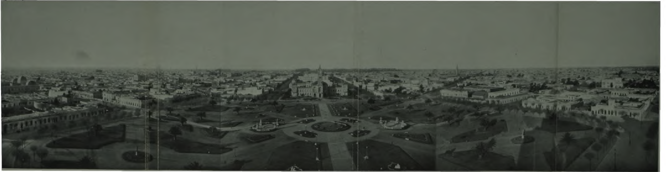
LA CIUDAD DE LA PLATA. — Vista tomada desde los altos del edificio en construcción de la Catedral (de SO. a NE.) \
