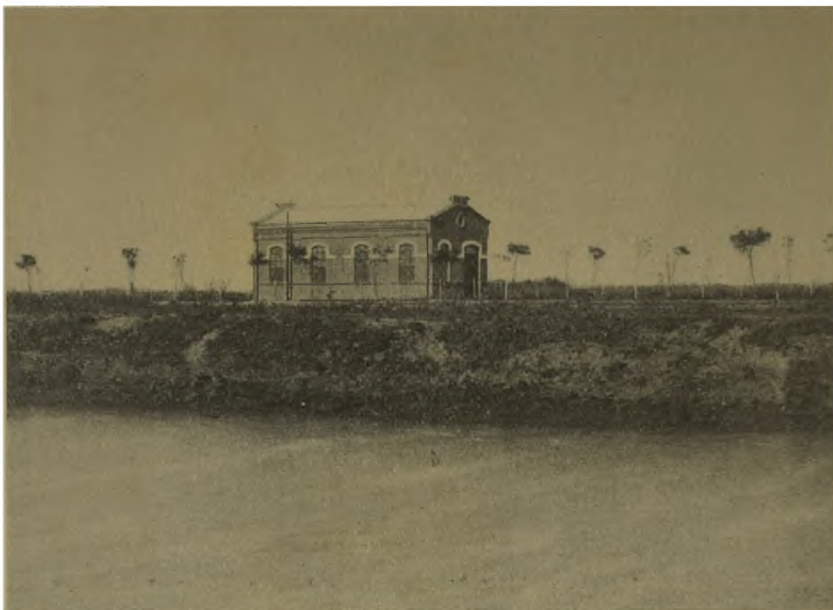
FACULTAD DE CIENCIAS FÍSICO-MATEMÁTICAS ( Estación experimental de hidráulica ). Vista de la casa de bombas (en primer término el canal oeste del Dique de cabotaje de La Plata)
